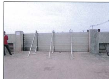
รูปที่ : 31 การทดสอบติดตั้ง อุปกรณ์ STOP LOG
