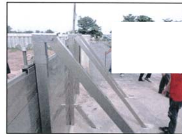
รูปที่ : 29 การทดสอบติดตั้ง อุปกรณ์ STOP LOG
